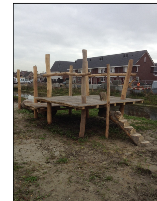
Voorbeeld plateau (startpunt kabelbaan)
