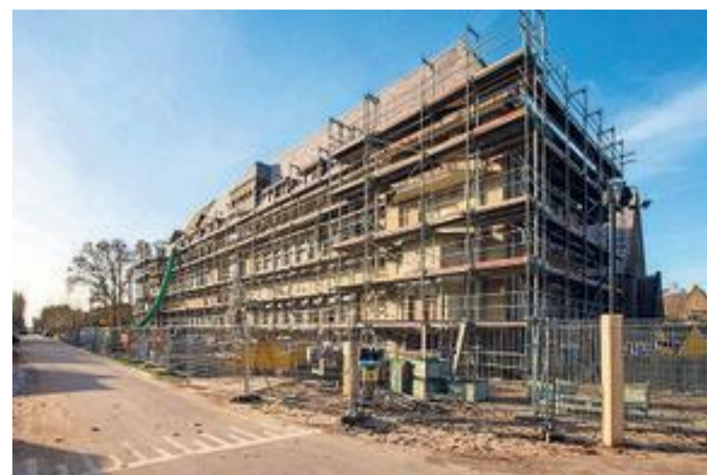
Het Hoofdgebouw in de steigers.
